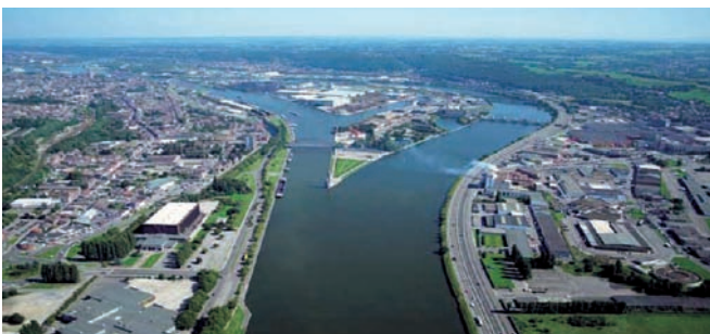
Bild 4. Deutscher Binnenhafen in einem Industriegebiet.
